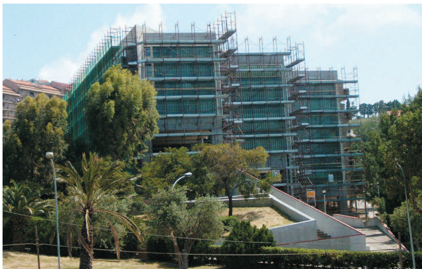
Immagine in ristrutturazione
